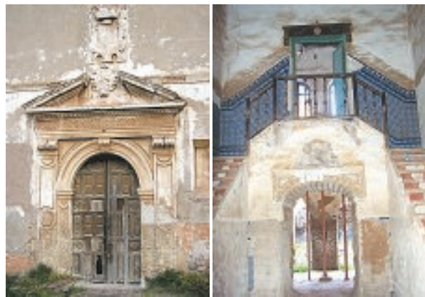
Imagen de la puerta principal de acceso al monasterio (izquierda) y la entrada al claustro (derecha)
