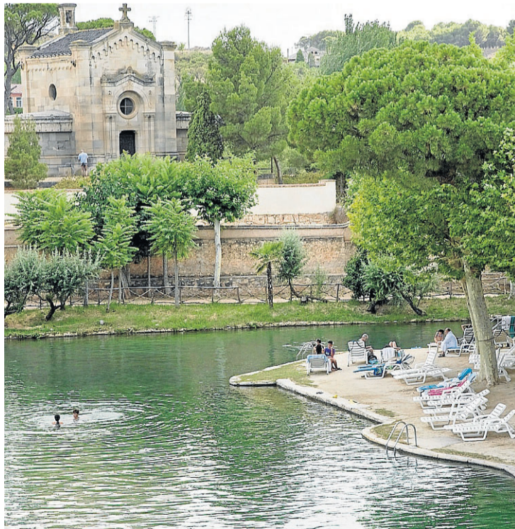
Vista de un lugar tan paradisíaco como Alhama de Aragón. JESÚS MACIPE
